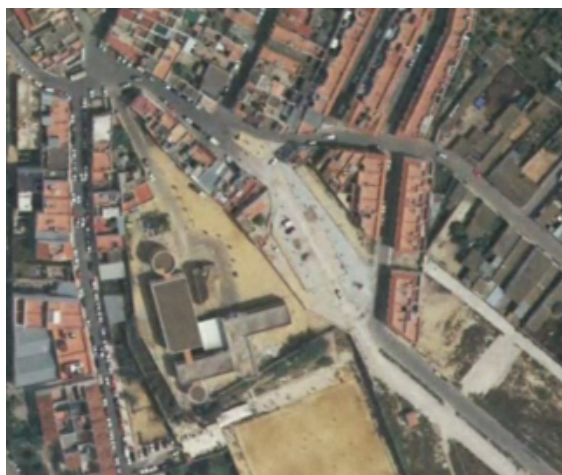
Ortofotografía extraída del vuelo PNOA 2005 en la que se aprecian las obras de urbanización de la Avd. del Calvario
